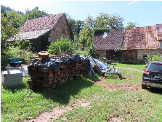
Im Hintergrund die linke Scheune (222)
